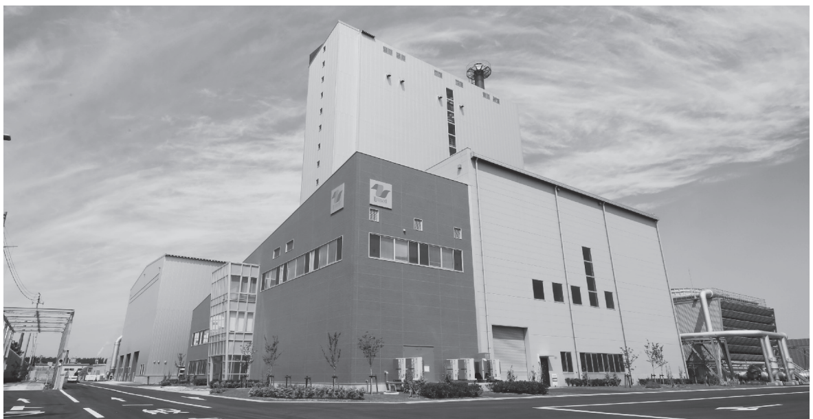
写真1 / ユナイテッドリニューアブルエナジー(株)のバイオ発電所全景
